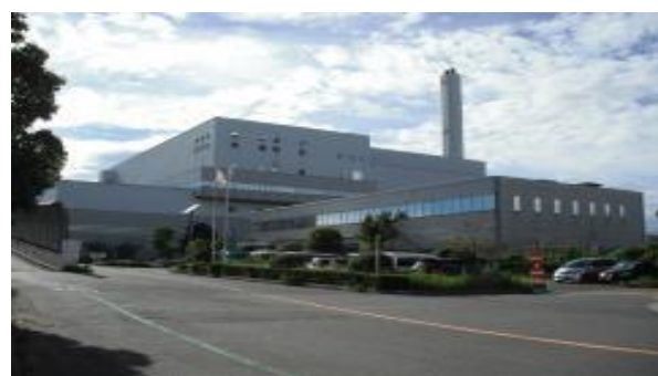
クリーンセンター東工場第二工場
