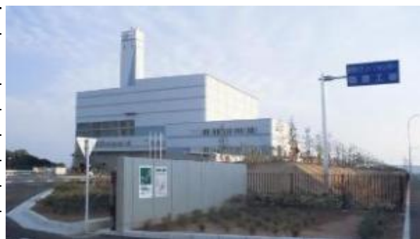
クリーンセンター臨海工場
