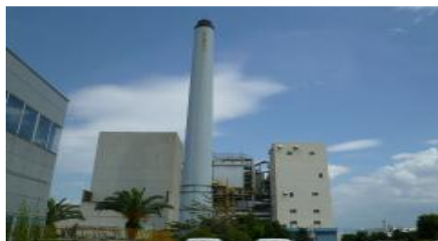
クリーンセンター東工場第一工場
