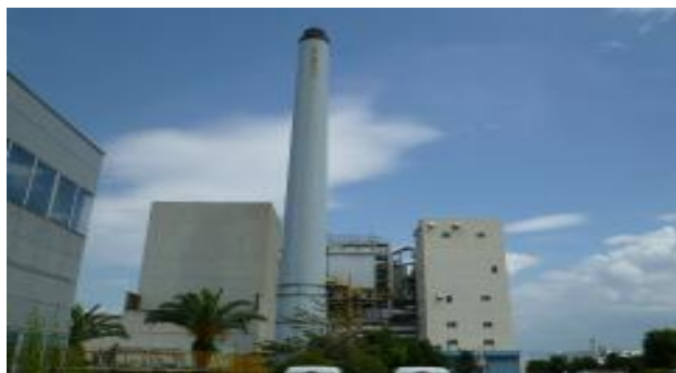
クリーンセンター東工場第一工場
