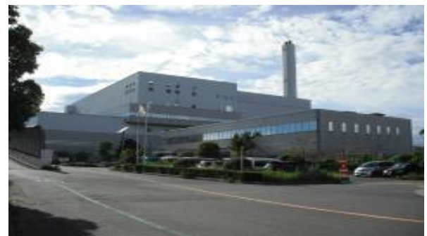
クリーンセンター東工場第二工場
