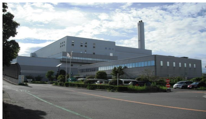
クリーンセンター東工場（第二工場）
