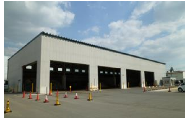
クリーンセンター東工場貯留施設
