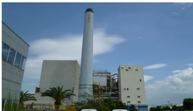
クリーンセンター東工場（第一工場）
