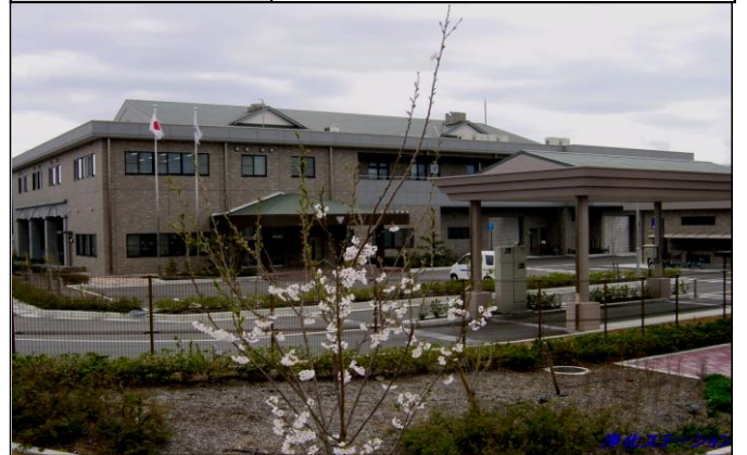
浄化ステーション
