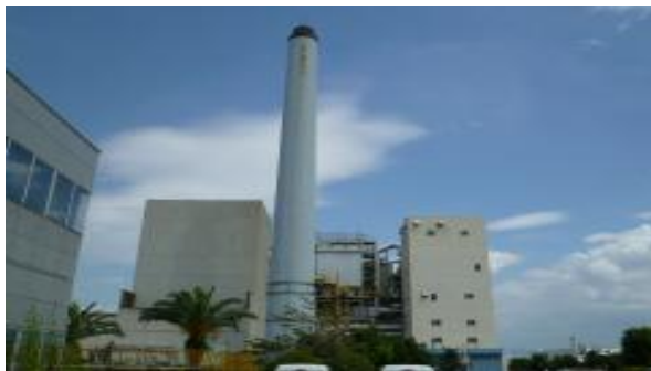
クリーンセンター東工場第一工場
