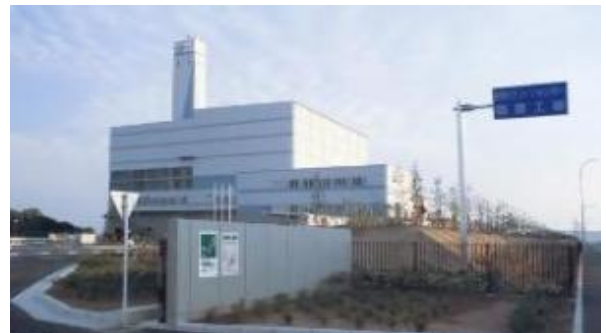
クリーンセンター臨海工場
