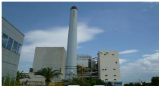
クリーンセンター東工場第一工場
