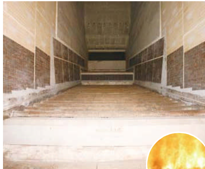
■焼却炉 様々なごみ質に対応して850℃以上の高温で焼却を行い、ダイオキシン類の発生を抑制します。
