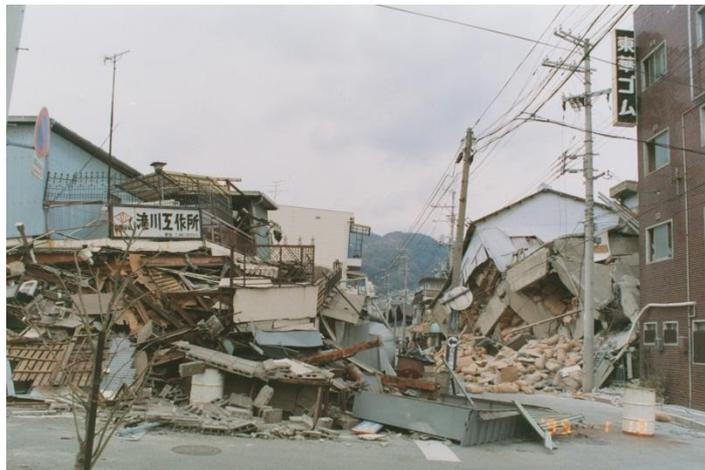
図-9 建物倒壊による道路閉塞の事例
