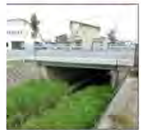
※通常地覆水切りが桁下まで打ら下ろされているため、横桁位置が確認できない。
