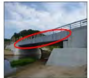
※地覆水切りが桁下まで打ち下ろされているため、横桁位置が確認できない。
