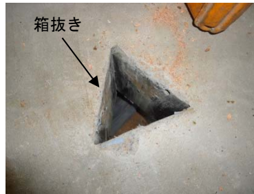
②箱抜き型枠の撤去
