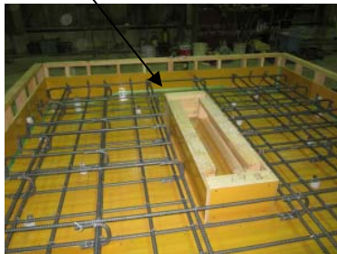
①箱抜き型枠の設置
