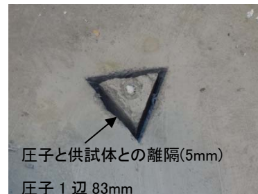
⑤発泡型枠の撤去
