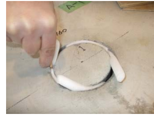
③離隔調整材 (φ13mm) 上面側より1重目設置
