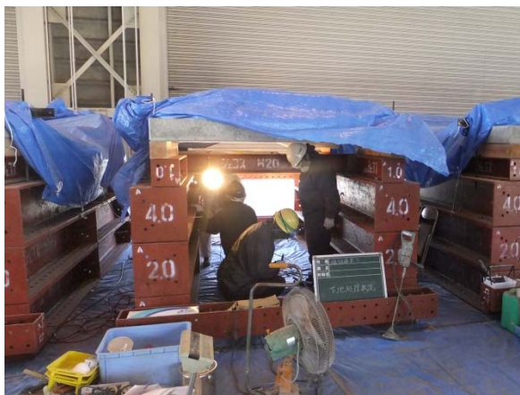
(a) 施工状況 (架台設置)
