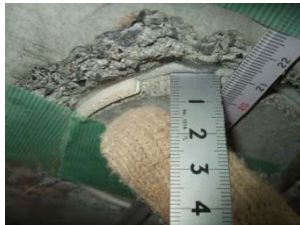
⑦離隔調整材設置位置計測 底面より5mm確保
