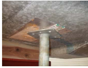
②復旧コ7仮受け
