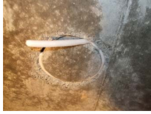
⑤離隔調整材 (φ8mm) 下面側より設置
