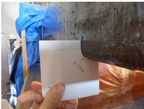
(a) 角部面取り状況
