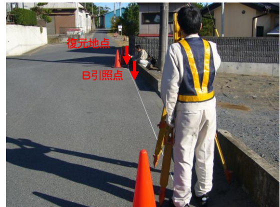
A引照点でのTSによる視準(A引照点～B引照点～復元地点)
