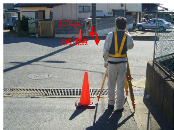
基準点埋設後の点検
