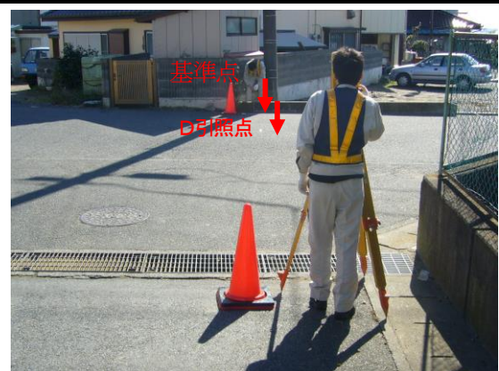
基準点埋設後の点検
