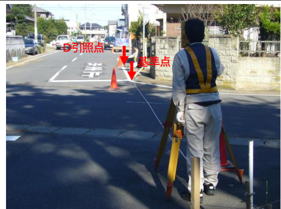
基準点埋設後の点検
