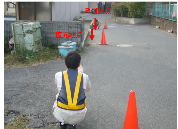
A引照点での基準器による視準(A引照点～復元地点～B引照点)
