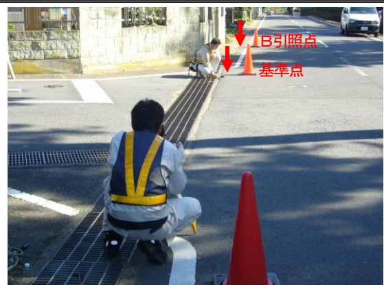
基準点埋設後の点検
