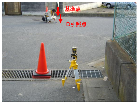
基準点埋設後の点検
