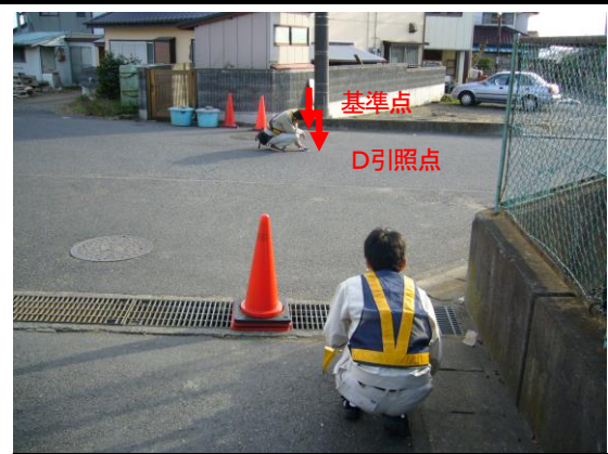
基準点埋設後の点検
