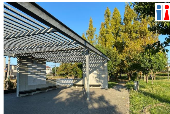
⑤ 大和川公園（堺市）
