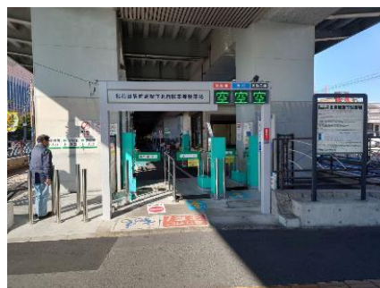
機械式ゲート（北花田駅高架下北駐輪場）
