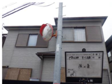
カーブミラー破損【対応前】
