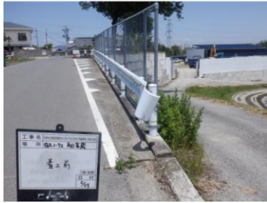
防護柵破損【対応前】
