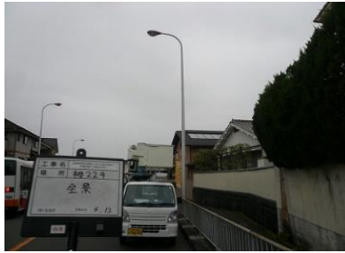
照明灯不点灯【対応前】
