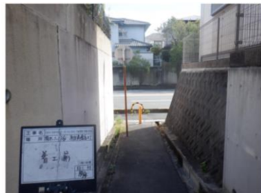
標識破損【対応前】
