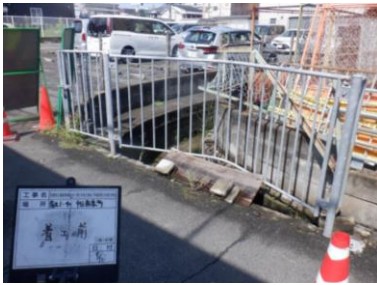
防護柵破損【対応前】
