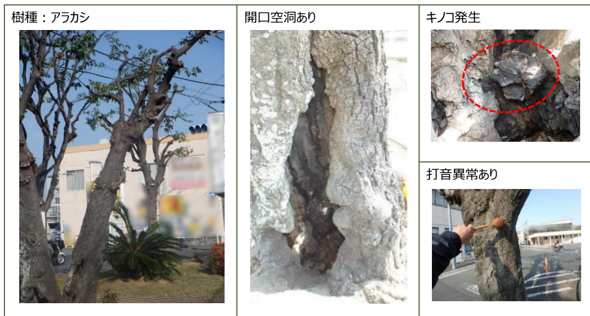
図 2-4 健全度 C（不健全）の判定事例
