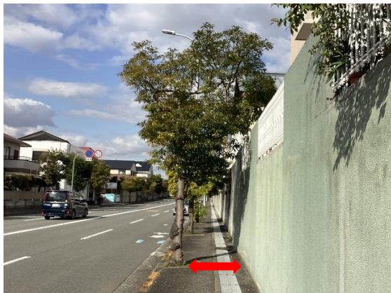
歩道の有効幅員不足
