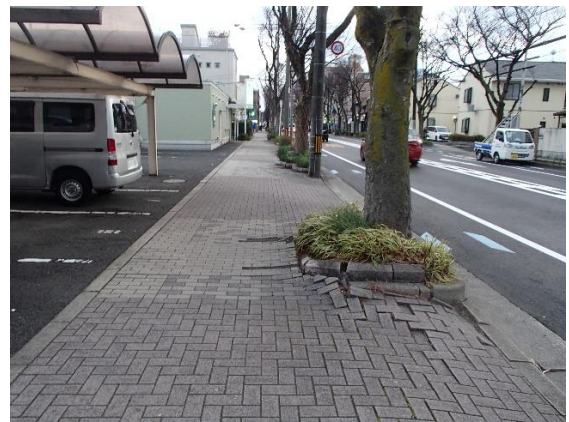
図 2-8 根上りによる通行支障の事例
