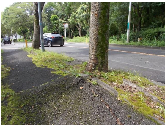
図 2-8 根上りによる通行支障の事例
