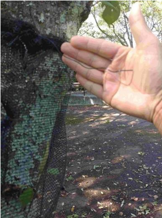
悪例③針金端部処理無。飛び出ているので緑地利用者のケガの元となる。
