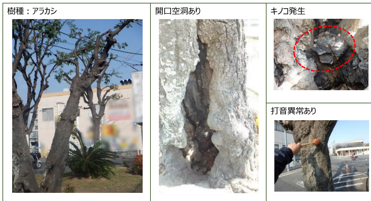
図 2-4 健全度 C（不健全）の判定事例
