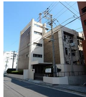
衛生研究所（本館）の外観
