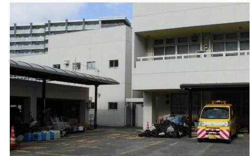
車両・資材倉庫
