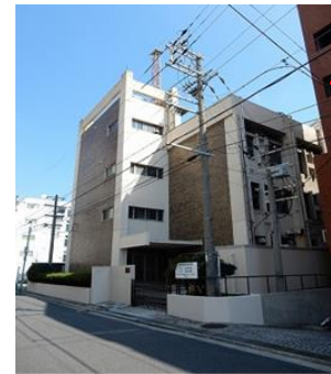
衛生研究所（本館）の外観
