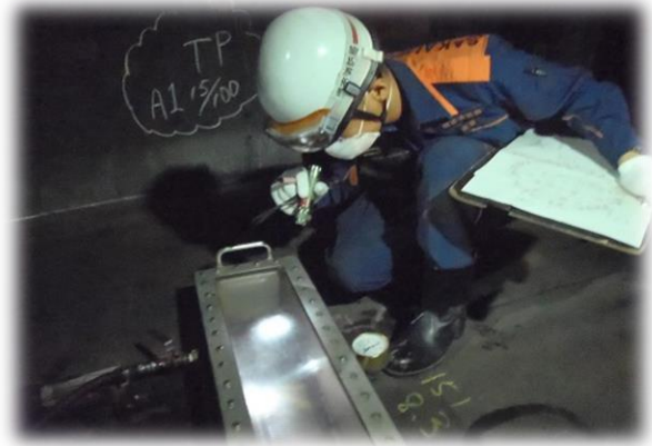
タンク内部の溶接部検査風景
