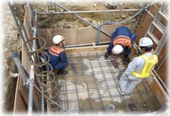
地下タンク配筋検査風景
