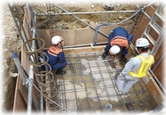
地下タンク配筋検査風景
