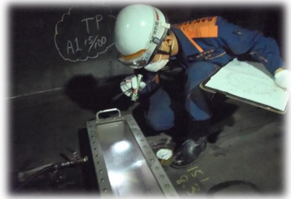
タンク内部の溶接部検査風景
