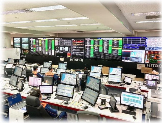
消防指令センター
