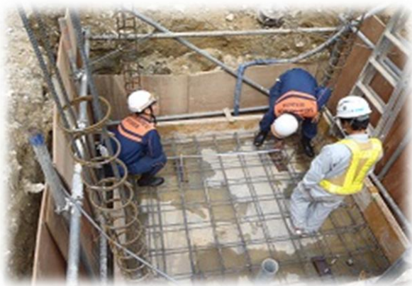
地下タンク配筋検査風景
