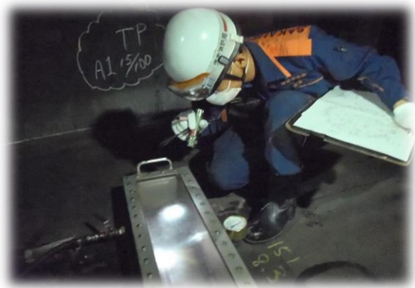
タンク内部の溶接部検査風景
