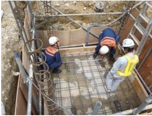
地下タンク配筋検査風景
