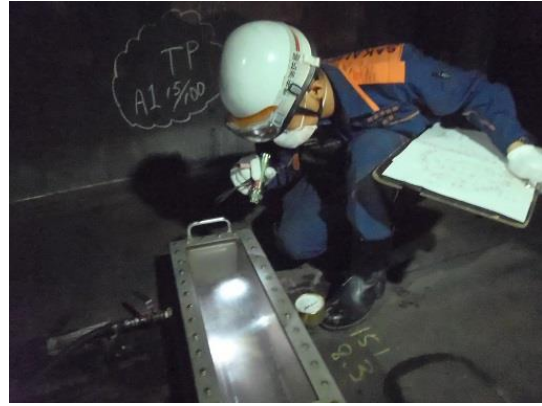
タンク内部の溶接部検査風景
