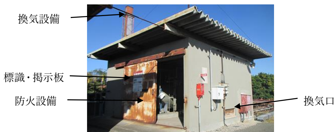
平屋建の建築物内に設けられたタンク室の例
