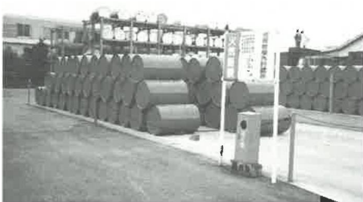
地盤面をコンクリート舗装した例
