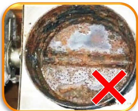
👉 固着した油脂により作動しなくなった防火ダンパー
