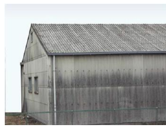
石綿含有スレート波板
