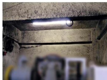
機械室吸音材
