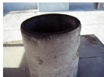
煙突用石綿断熱材
