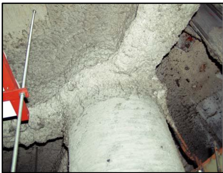
鉄骨耐火被覆材 (柱や梁の鉄骨部分)
