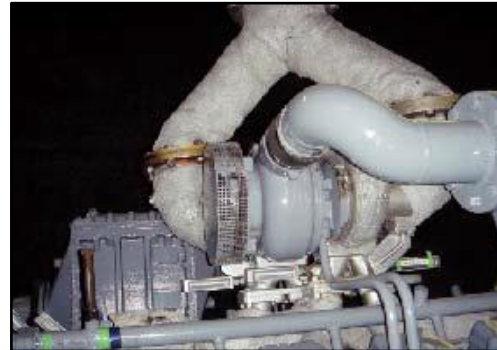
石綿含有保温材（設備配管）
