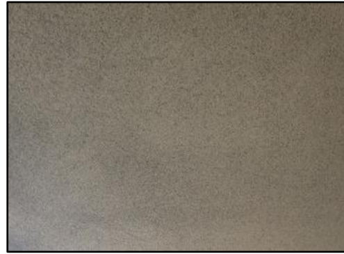
石綿含有内外装仕上塗材（外壁等の仕上材）
