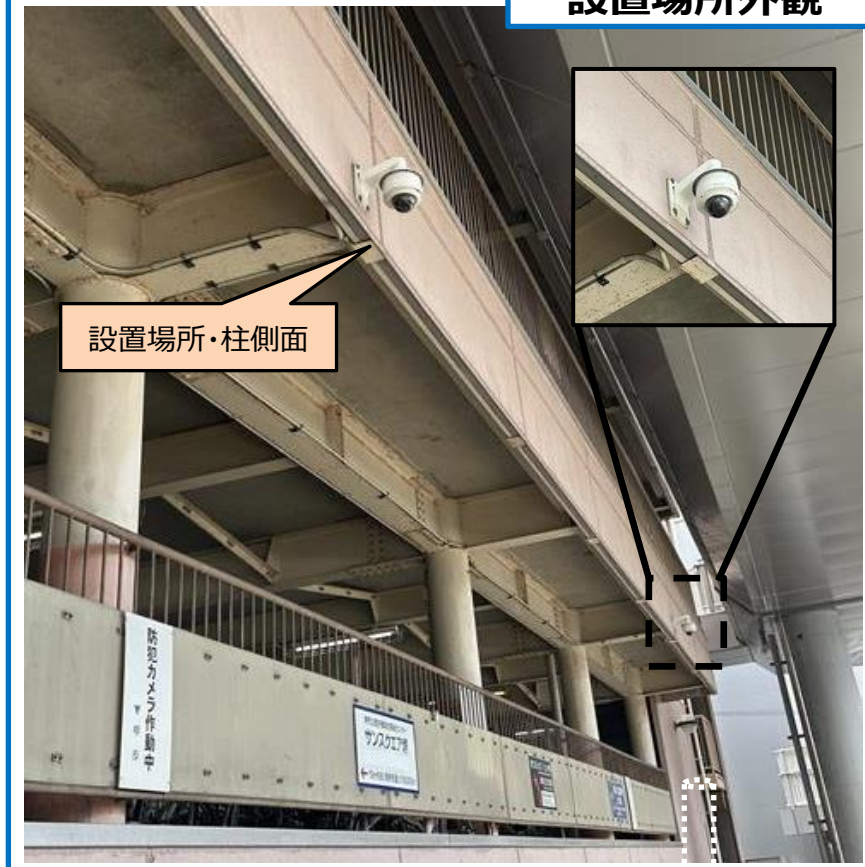
設置場所外観
