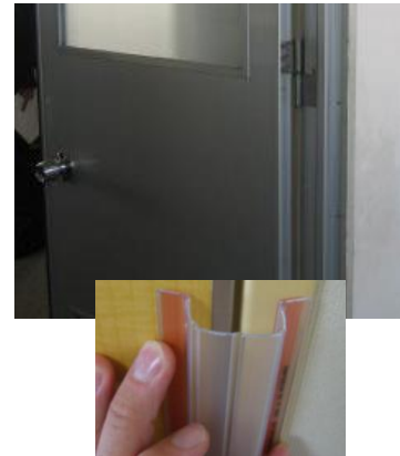
図書室の扉と枠の間に指詰め防止器具を設置する
