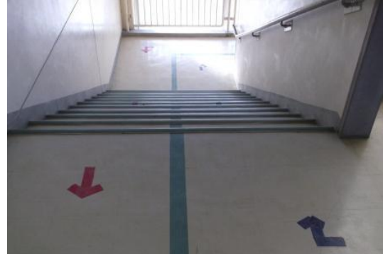
階段部に、衝突防止のため上り下りの表示をする
