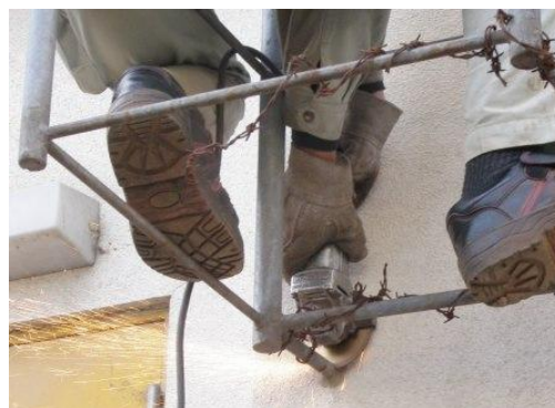
低い位置のタラップを撤去する
