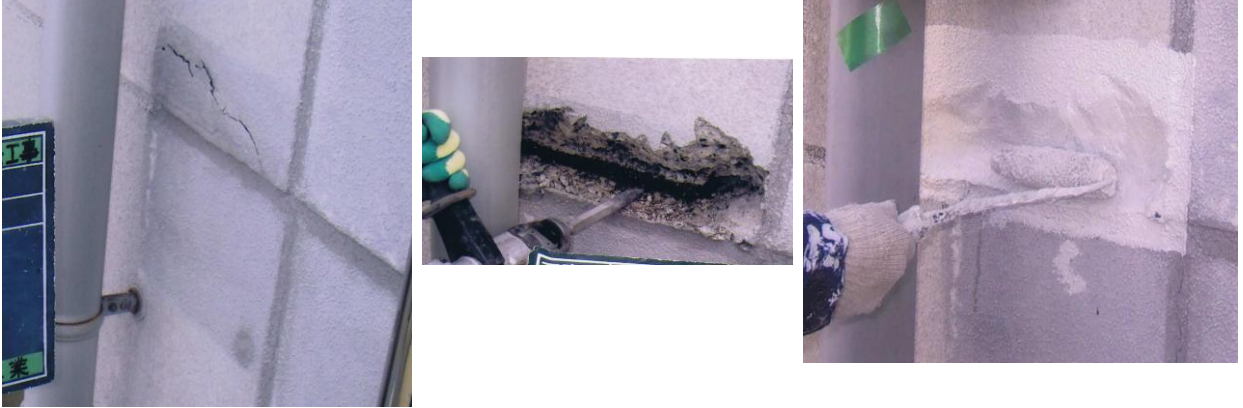
外壁補修の前後の様子
