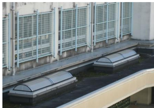
庇(天窗あり)に乗り移ることができる窓に防球ネットをつける
