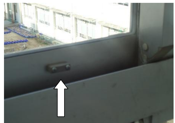
窓に開口幅制限のストッパーをつける
