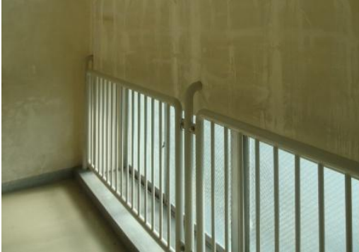
階段踊り場ガラス窓の手前に面格子を設置する
