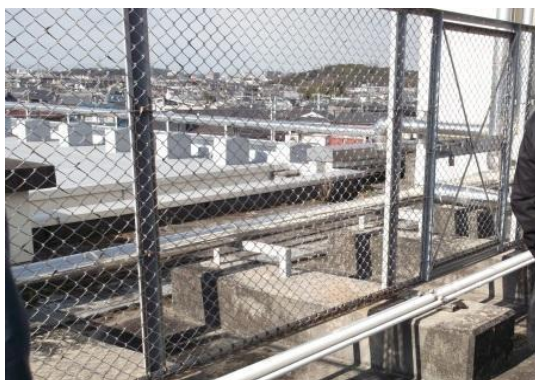
屋上に防護フェンスをつける
