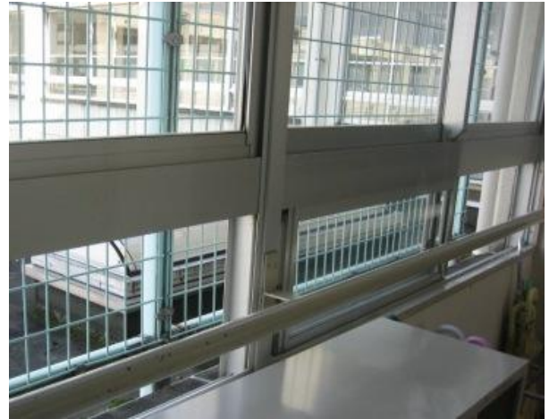
廊下の窓に防球ネットをつける
