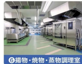
6 揚げ・焼物・蒸物調理室
