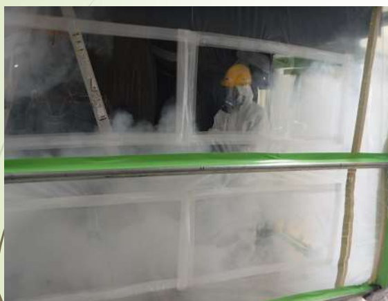
スモークマシンによる漏えい確認
