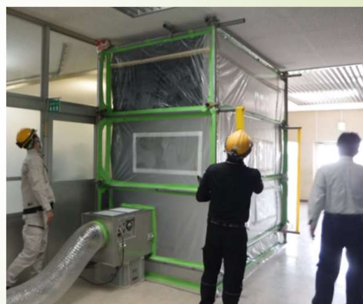
スモークマシンによる漏えい確認
