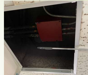
点検口付近の風速測定
