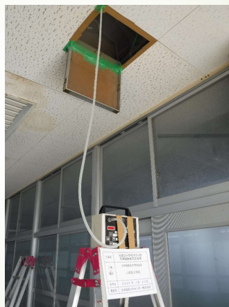
測定器設置状況 (点検口 閉)
