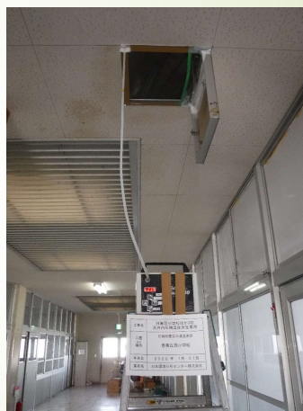
測定器設置状況 (点検口 閉)
