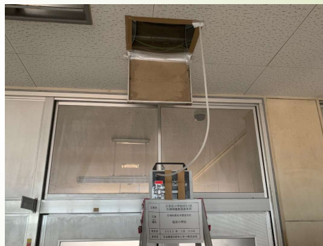
測定器設置状況 (点検口 閉)
