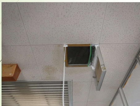
点検口養生状況
