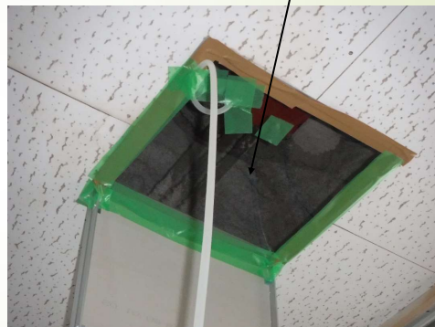
点検口養生状況
