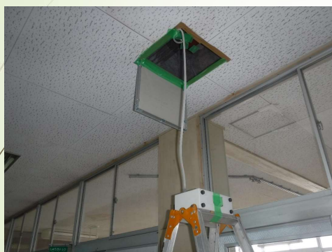
測定器設置状況 (点検口 閉)
