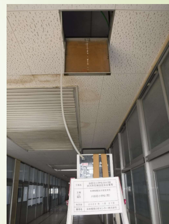
測定器設置状況 (点検口 開)
