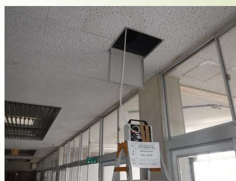
測定器設置状況 (点検口 開)
