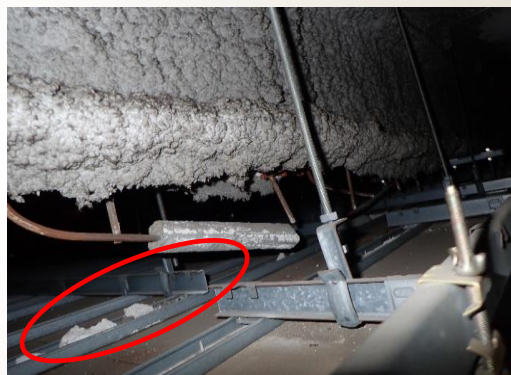
天井内の状況
