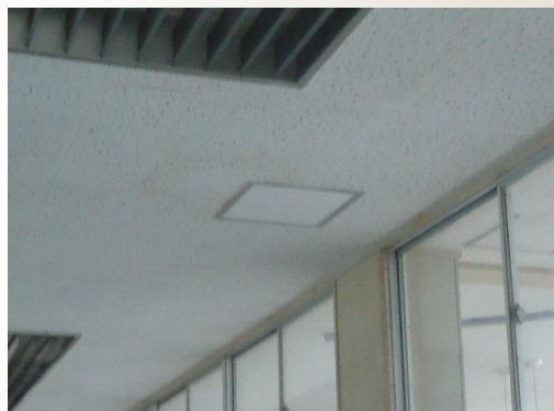
天井点検口 補修後
