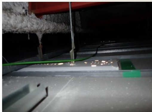
天井内の状況
