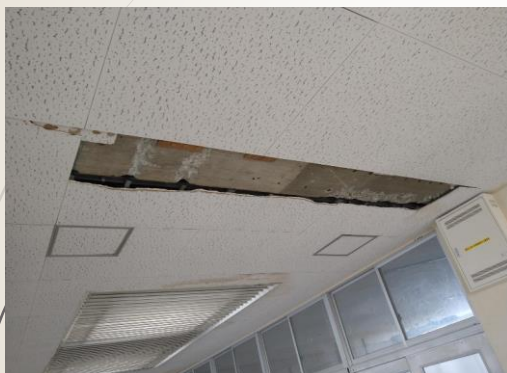
天井ボード補修前
