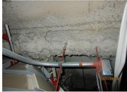
天井内の状況
