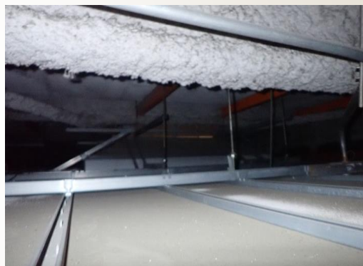
天井内の状況
