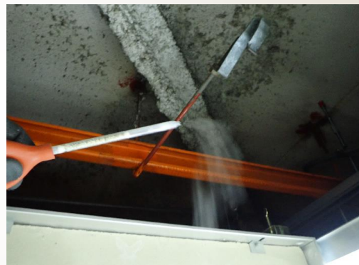
天井内の状況
