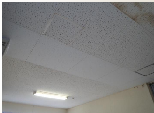
天井ボード補修後
