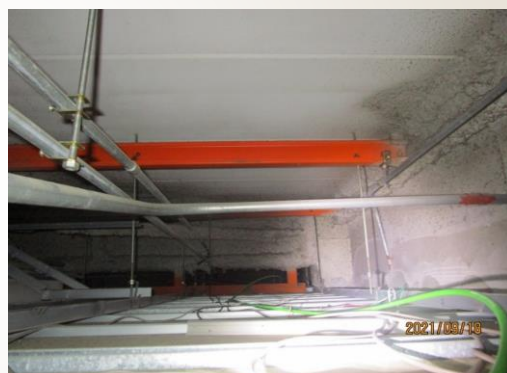
天井内の状況
