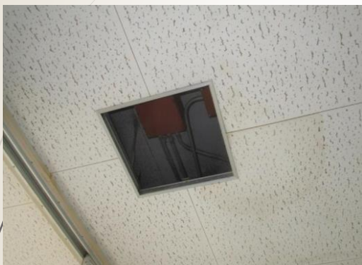
天井点検口 補修前
