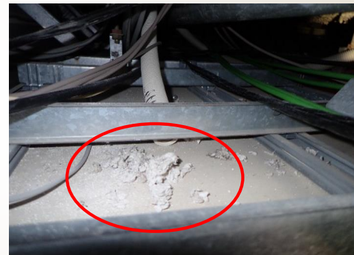
天井内の状況
