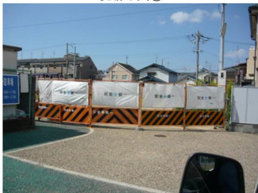
現場写真①
