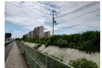
< 北西エリアの現況 >
