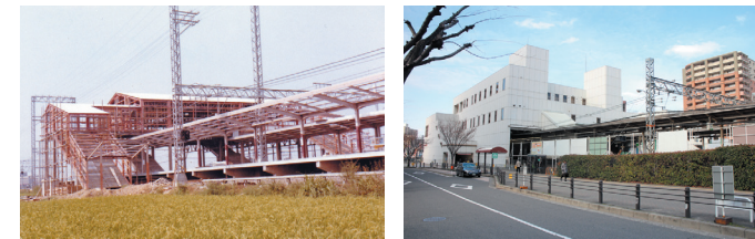
建設中の中百舌鳥駅(昭和45年頃)と現在の比較
