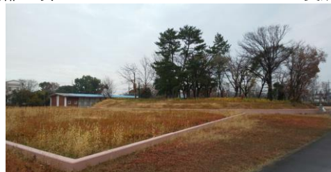
範囲を擁壁で示した前方部
