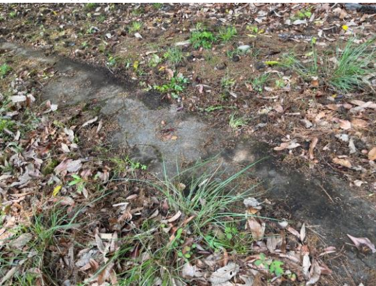
コンクリート構造物
