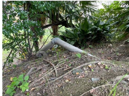
露出した配管
