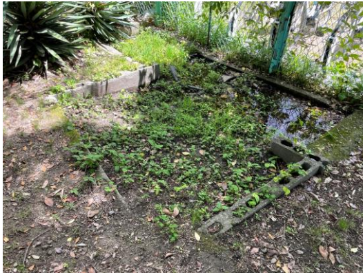
コンクリート構造物
