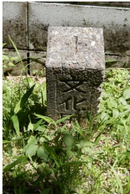
埋没する境界杭
