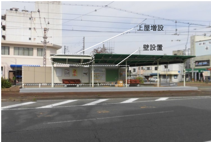
綾ノ町上り停留場(施工箇所)
