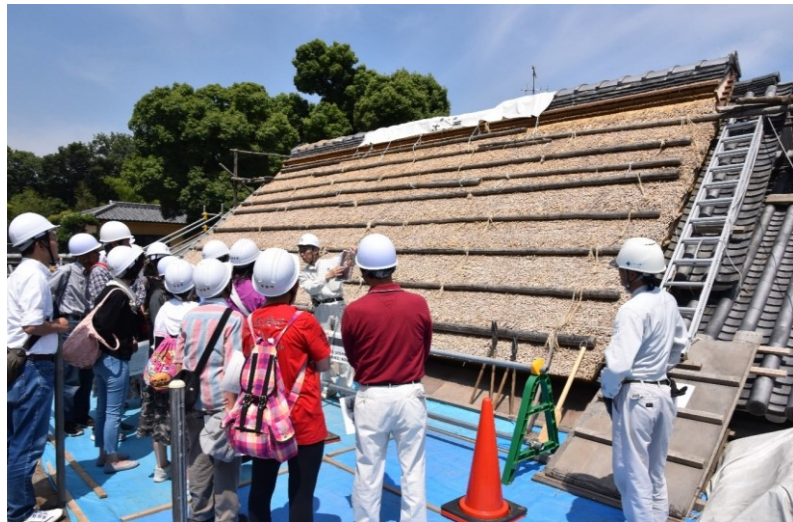
修理中の現場公開の様子(平成30年6月3日) 59名参加
