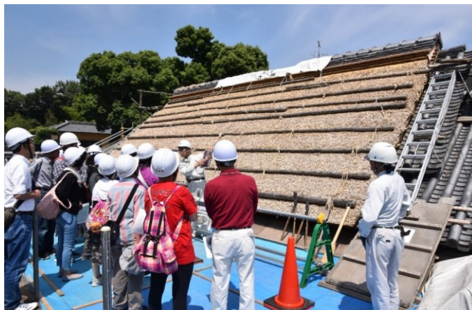
修理中の現場公開の様子(平成30年6月3日)
