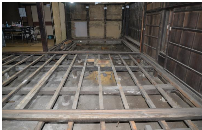
井上関右衛門家住宅(鉄砲鍛冶屋敷)保存修理工事写真
