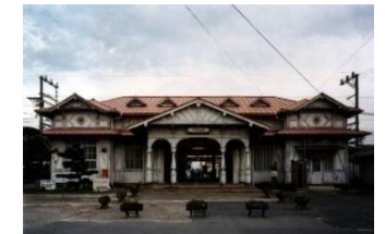
南海電気鉄道 南海本線 浜寺公園駅駅舎
