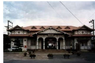
南海電気鉄道 南海本線 浜寺公園駅駅舎
