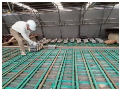
記名瓦を葺いている様子
