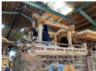
菱木神社保存伝承用具等整備事業でのだんじり修理の様子 (令和4年8月18日撮影)
