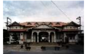
南海電気鉄道 南海本線 浜寺公園駅駅舎
