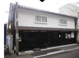
町家外観修景整備の事例(H27)
