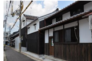
鉄砲鍛冶屋敷保存修理工事の様子
