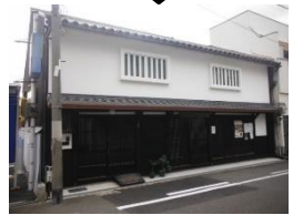
町家外観修景整備の事例(H27)
