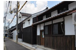
鉄砲鍛冶屋敷保存修理工事の様子
